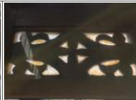
MANCHAS DE ÓXIDO EN EL VIDRIO A-06
