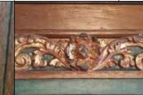
OXIDACIÓN Y ENROJECIMIENTO DE ORNAMENTO
