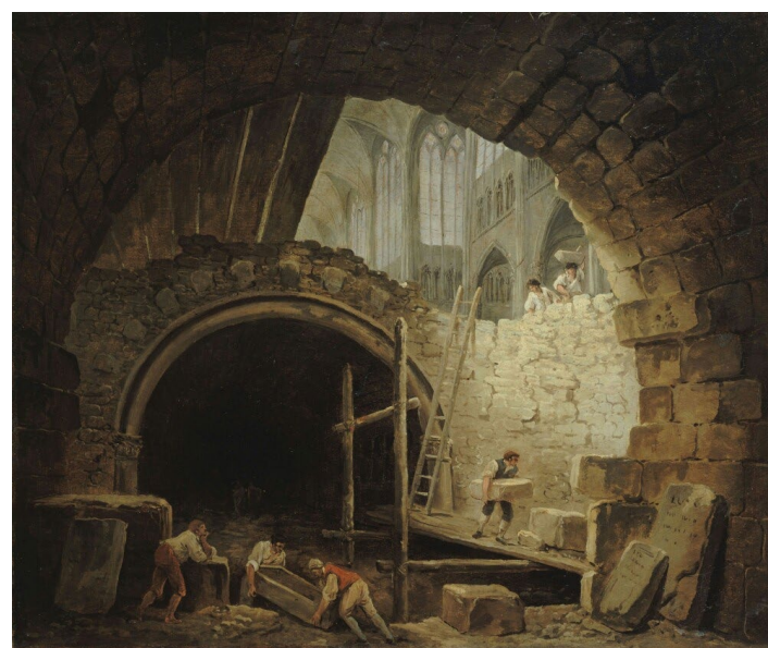
Desmontaje de las bóvedas del monasterio, s/f
